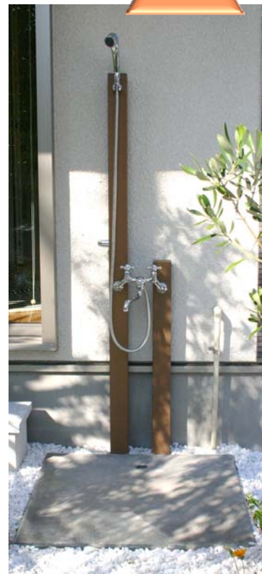
現場施工コンクリートの排水部
